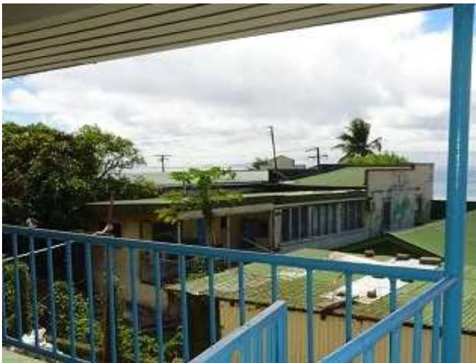
山側斜面からの外観
