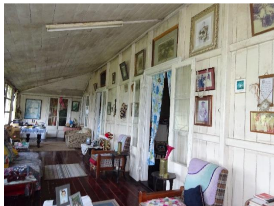
Fig.2-29 縦羽目板の内張 (外開き)
