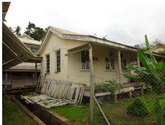
Fig.2-18 ベランダの妻側の垂れ壁
