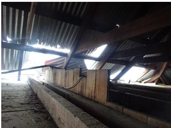
Fig.1-11 屋根裏まで貫通する壁
