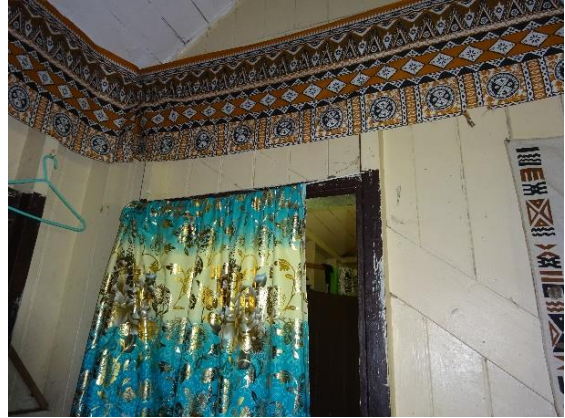
Fig.1-8 筋交を切断して扉を追加している
