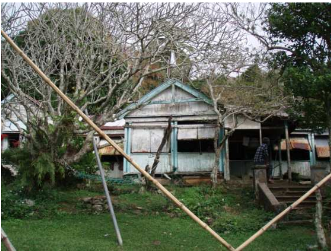
2016年台風倒壊前外観(2007年九州大学撮影)
