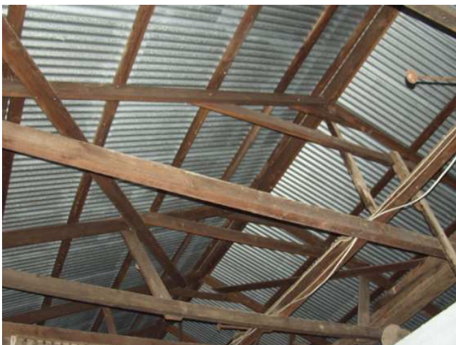
小屋組み(2007年九州大学撮影)
