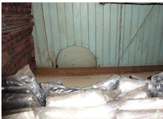
Fig.4-14 中2階で塞がれたシャンデリアベースの痕跡
