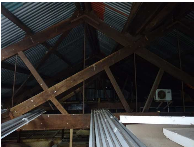
西棟小屋組み
