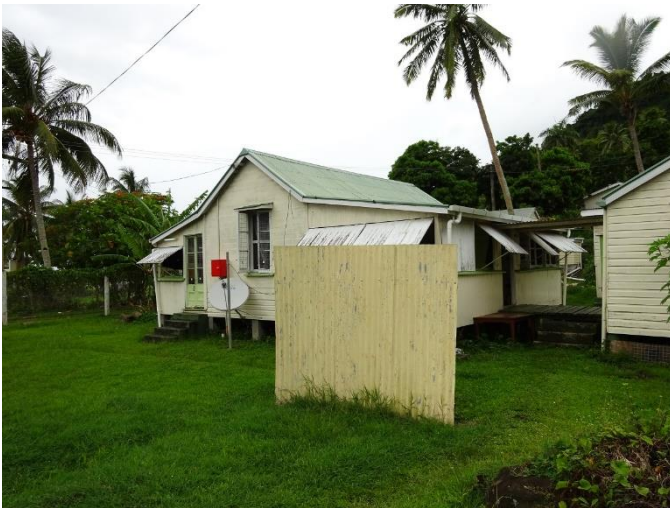
Fig.3-19 後方周辺室に設けられた連続窓
