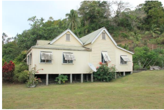
Fig.2-22 下見板と縦羽目板が混在した 外壁
