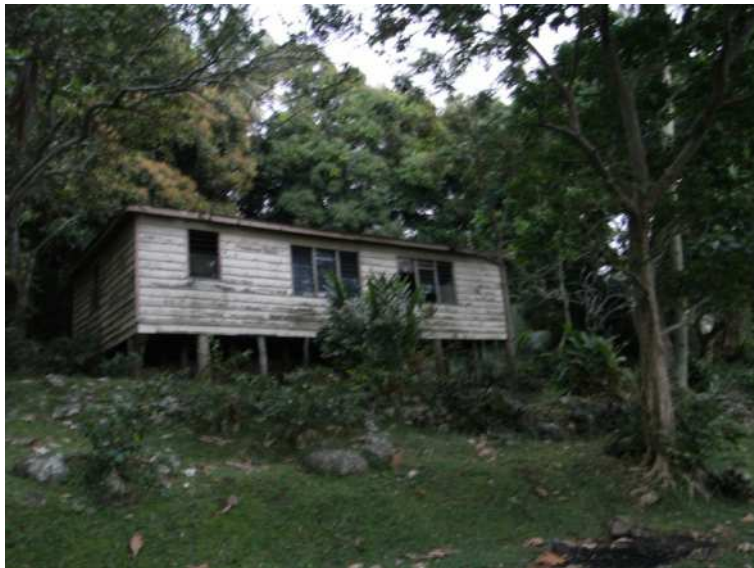
2016年台風倒壊前外観(2007年九州大学撮影)
