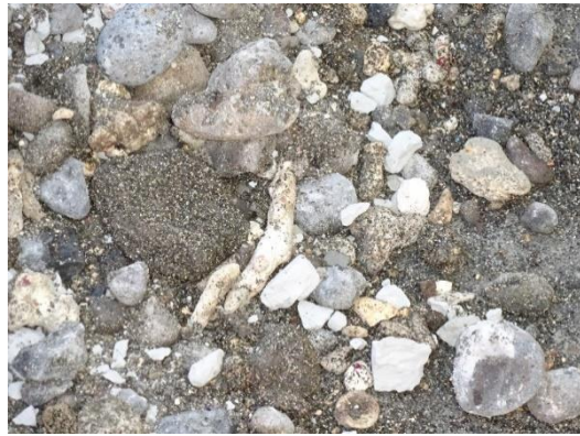
Fig.2-9 コンクリートの骨材に サンゴが混じる
