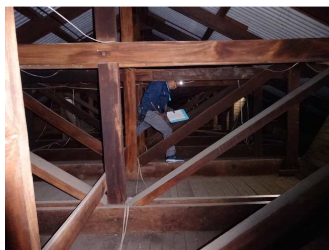
小屋組み(2014年九州大学撮影)
