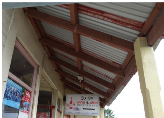
Fig.2-43 軒桁に接合された垂木
