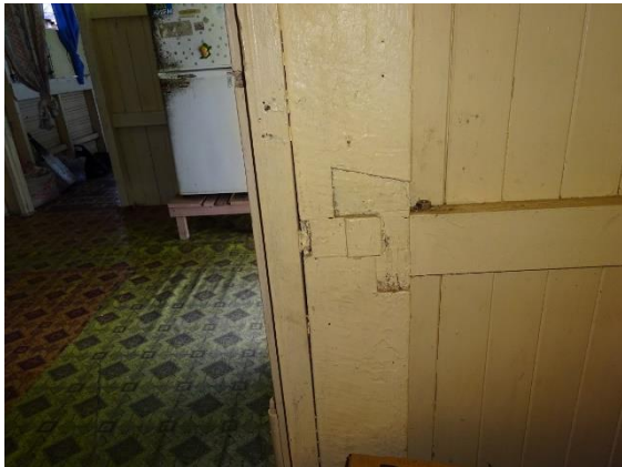
Fig.1-9 窓の下枠の痕跡
