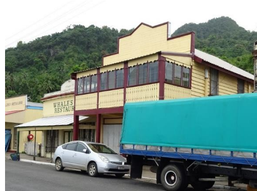
Fig.4-15 町家建築 b18 外観写真
