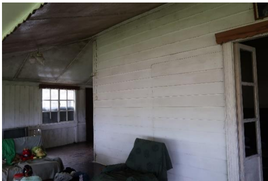
Fig.2-23 南京下見を用いた室内
