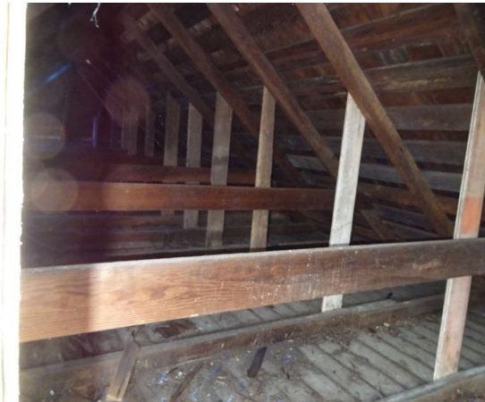
Fig.2-33 壁板で補強された小屋組
