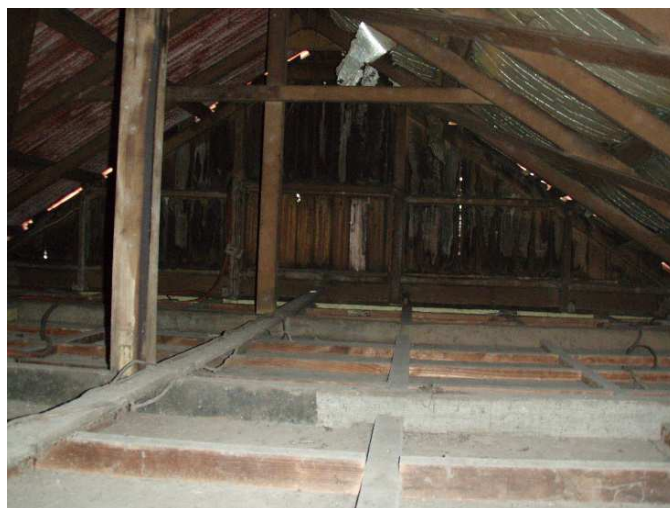
小屋組み(2007年九州大学撮影)
