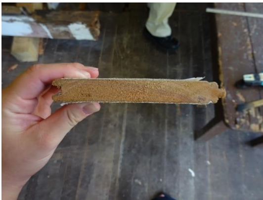
Fig.2-26 縦羽目板
