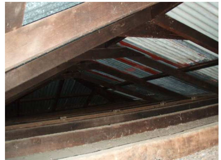
小屋組み(2007年九州大学撮影)
