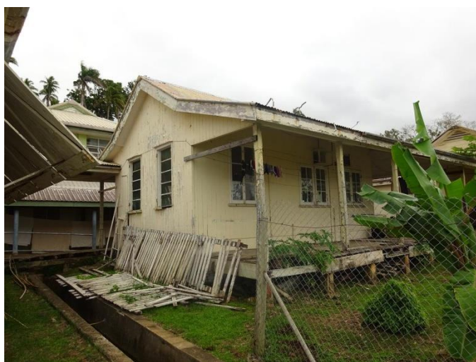
Fig.2-11 下屋がベランダのまま残るバンガロー型
