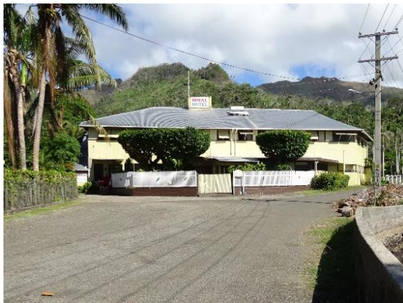
Fig.5-6 公共建築 ホテル外観
