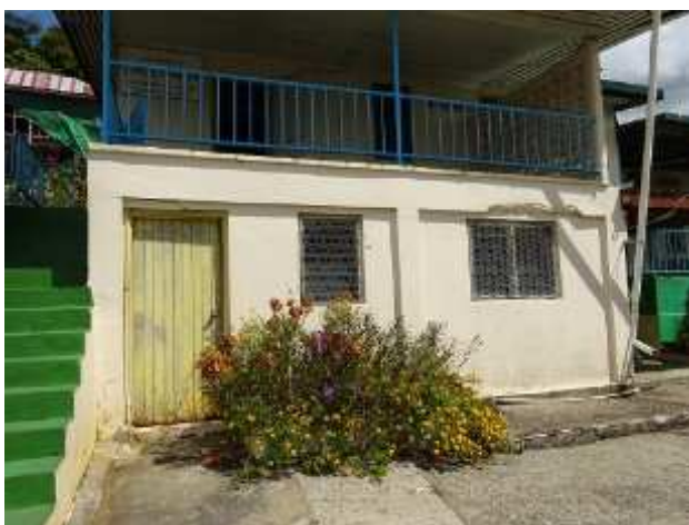
コンクリート地下階
