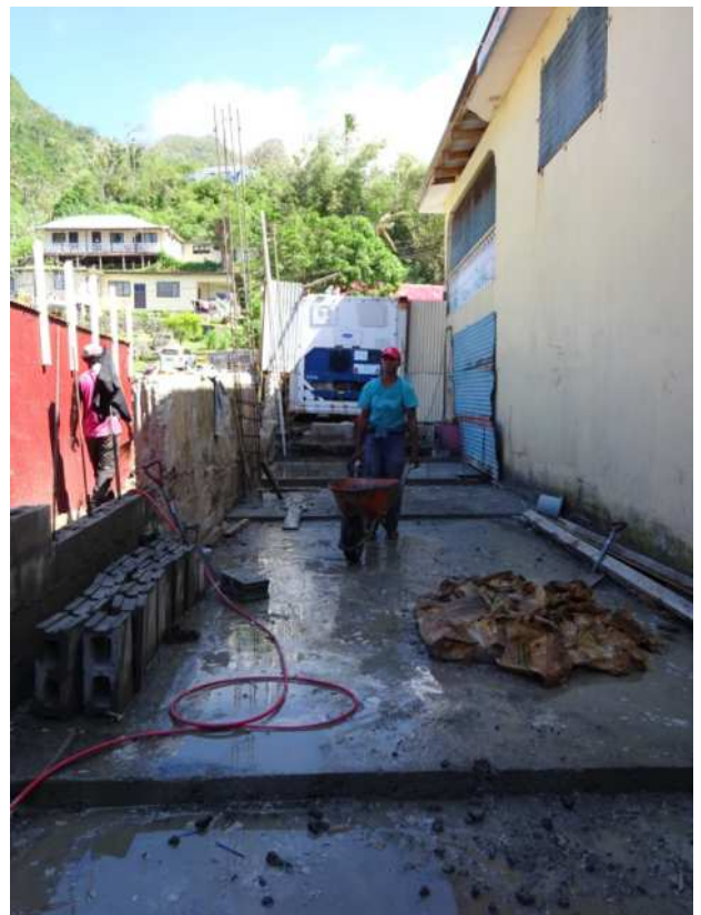
バックヤード増築時
