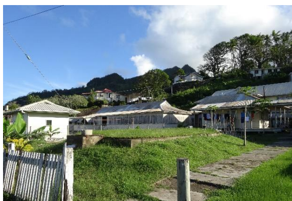
Fig.5-8 公共建築 病院外観
