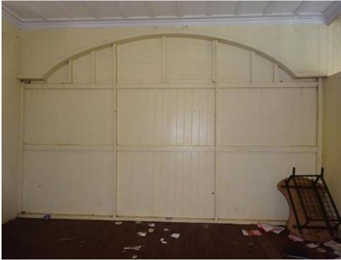
Fig.3-26 ms11の身舎に設けられたアーチ型の開口部。 現在は閉鎖されている
