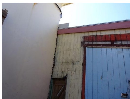
Fig.4-12 Fig.4-11を拡大 主屋後方の壁面に残るペンキ
