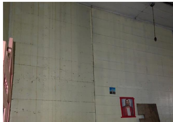
Fig.1-6 切断された壁の繋ぎ目
