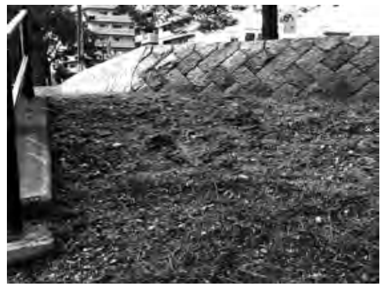
図5 堤防の様子の写真
