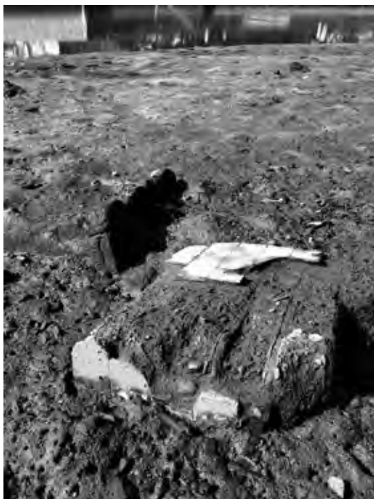
図4 柱状煉瓦構造物。表面には月星建陶社製小口平タイル。
