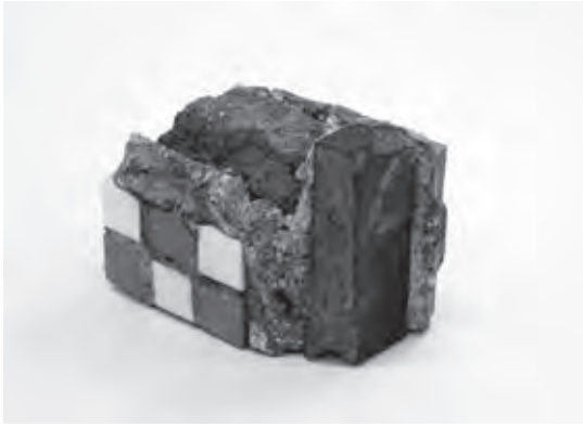
図13 区間Ⅰ河床で採集された瓦礫。煉瓦と瓦をセメントで固め、モルタルを塗ったところに単色無釉モザイクタイルを市松模様に張り付けている。
