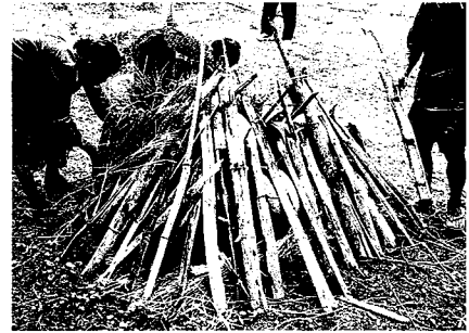
写真 52 裾部の割竹・稲藁の囲繞
