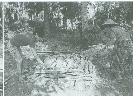
写真 59 竹による成形体配置の圍繞 [BPL]
