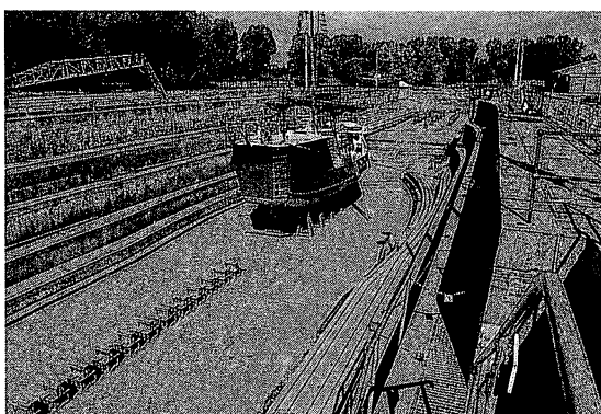
写真9 船を修理中のオランダ・ヘルフスルイスの二基直列式乾ドック。 手前：渠口側の段差壁、奥側：階段状壁。中央仕切り扉は開いている。
