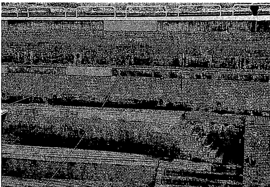
写真 15 ヘルフスルイス乾ドックの煉瓦積み壁面。オランダ積み、 煉瓦支え石は長方向がドック壁に沿っている。
