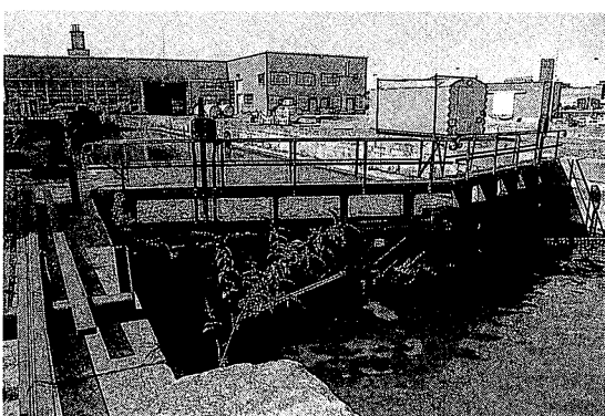
写真3 アントワープ3号乾ドックの木製扉と開閉用支柱。 てこの原理を利用し、支柱を人力で動かして扉を開閉する。
