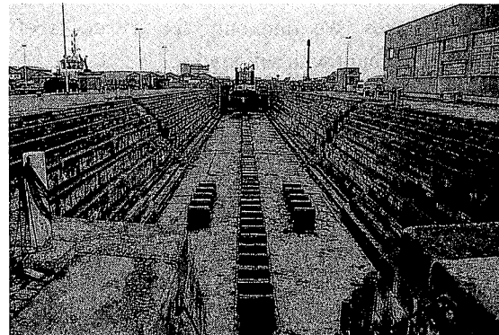
写真 22 19世紀中頃築造のアントワープ乾ドック。10段の段差、4箇所の昇降 用階段と荷物用滑り台はドック壁面に垂直向き。手前は渠頭部の昇降用階段。
