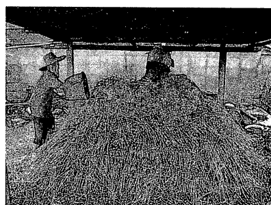
写真 115 天井部を藁灰で囲封 [H-R-011]
