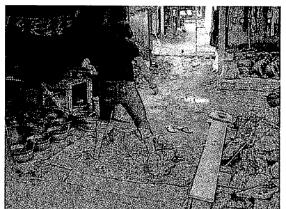
写真14 巻き返した粘土に踏み込む [H-G-121]
