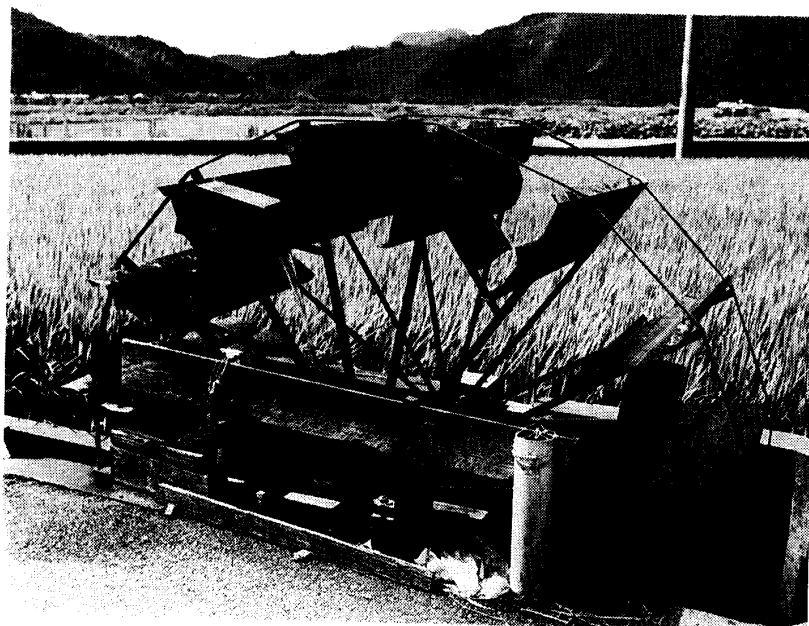
写真3 高知県宿毛市和田(水車番号8) 兼山溝に同じ形の水車4台が架かっている。鉄製だが伝統的形を保っている。内周枠がないので水筒取付用ブリキ棒を設けている。
