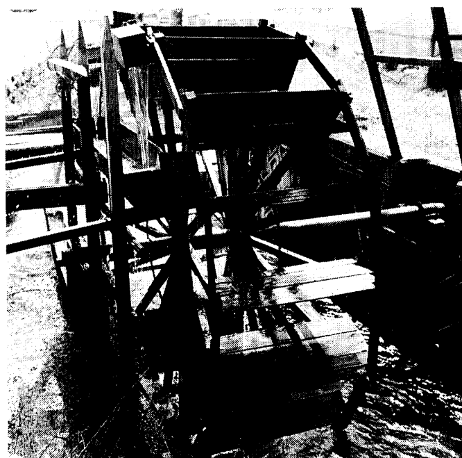
写真13 高知県安芸郡田野町（水車番号26） 心棒に鉄パイプを用いている以外は伝統 的構造を保っている。外周枠に杉板を使 用し、ハリに結わえているのが特徴であ る。
