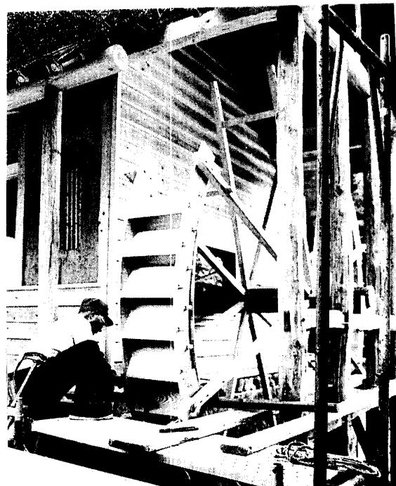
写真7 輪板ブロックとクモ手の接合。一人が輪 板ブロックを押へ，一人が栓を打ち込む。 心棒の軸受け部分には鉄角柱が打ち込ま れているのが見える。
