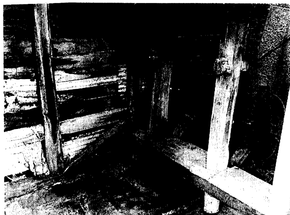
写真20 三本羽根板を四角鉄心棒へ固定する鉄枠
