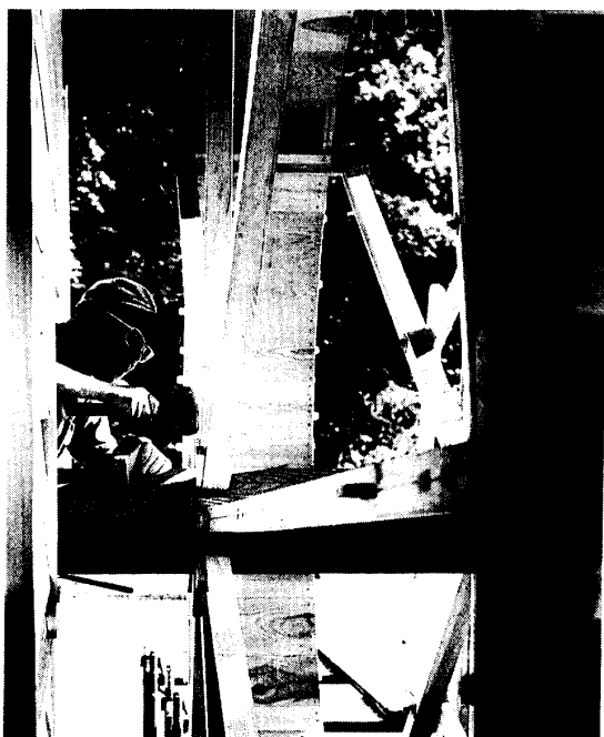
写真6 水輪の組み立て。クモ手が心棒へ差し 込まれ楔が打ち込まれている。 （愛媛県久万町，清水氏製作）
