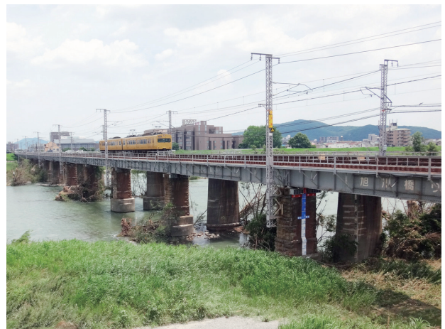
写真8. 現在のJR山陽本線 旭川橋梁。レンガの橋脚が見える。
